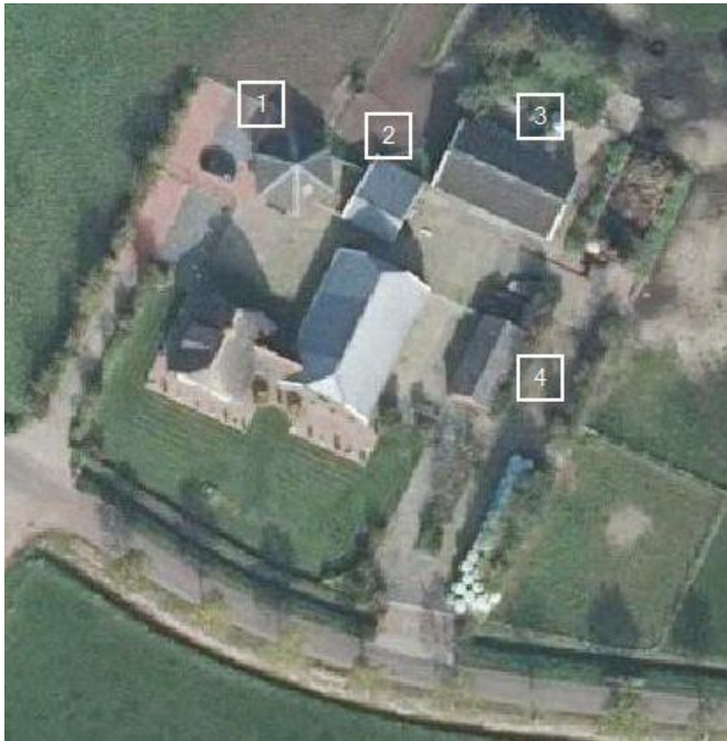
De te slopen opstallen: 1 garage; 2 veeschuur; 3 werktuigenberging en hooischuur; 4 paardenstal
