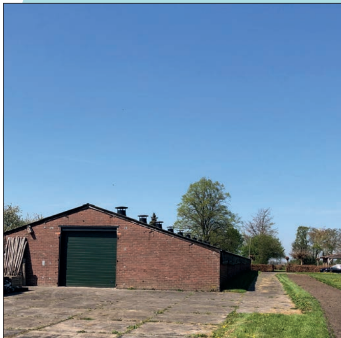
de te slopen kippenstal
