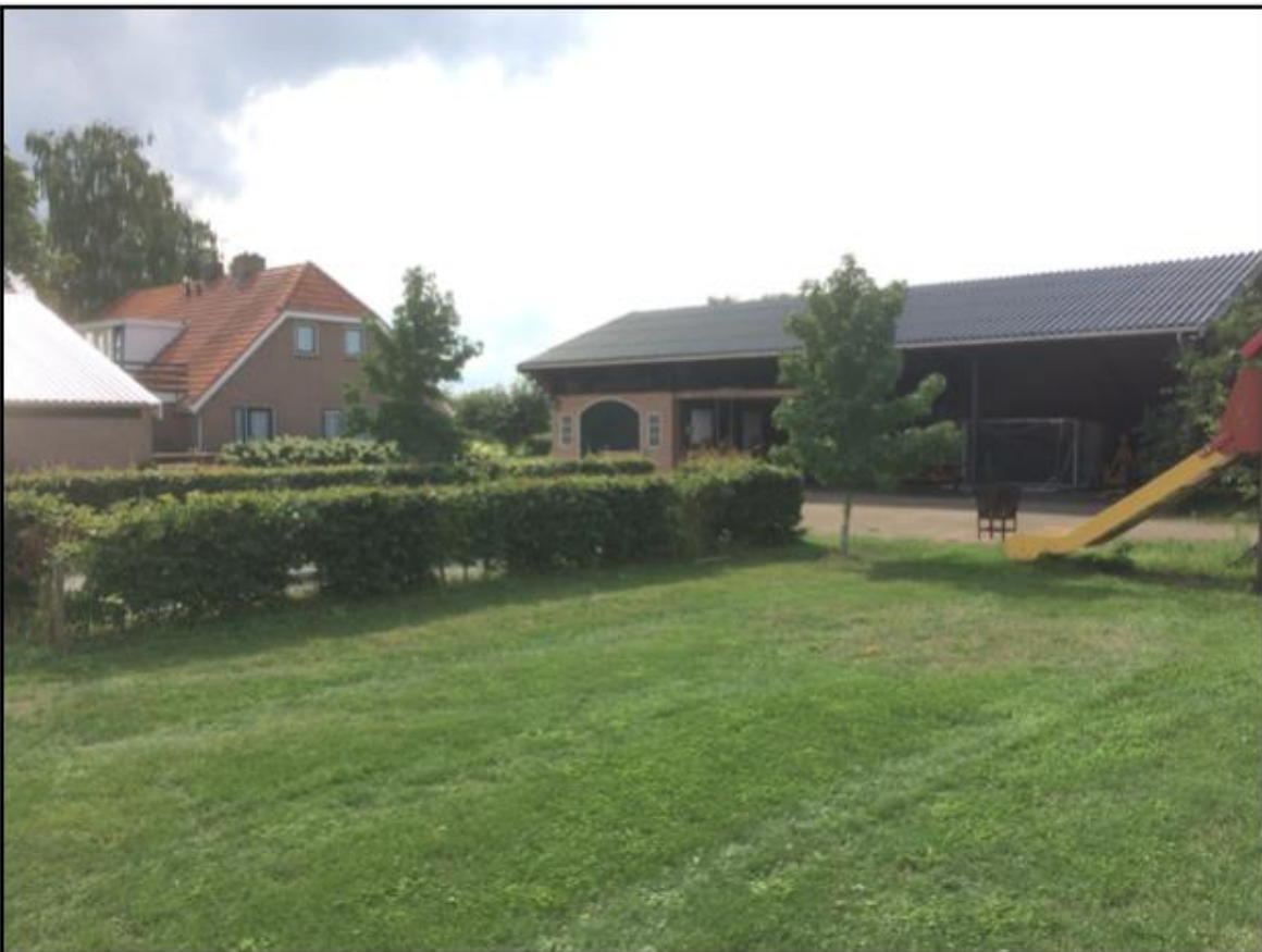
Figuur 2.3 Foto vanaf het erf
