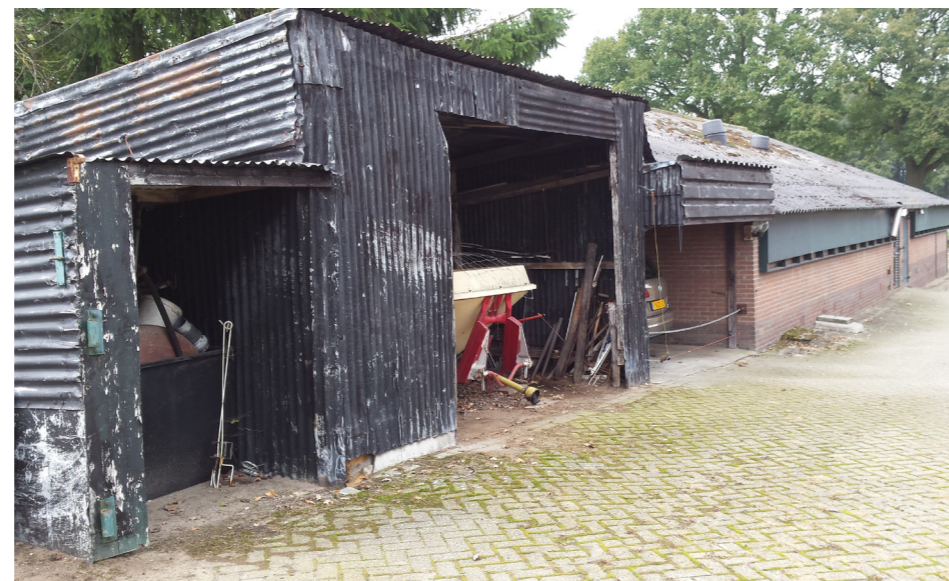
Afbeelding 4. Varkensstal (D) met aangebouwde werktuigenberging en autogarage
