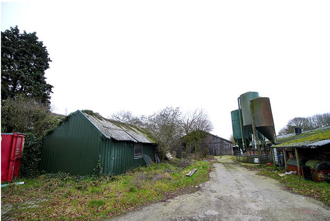
Planlocatie te slopen opstallen
