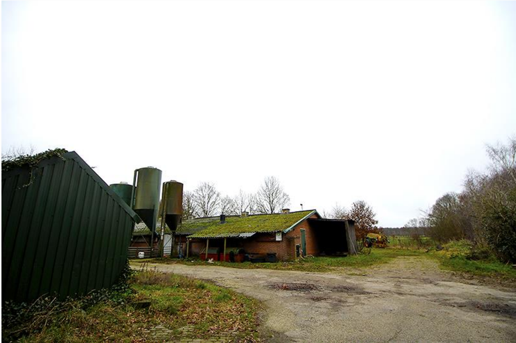
Planlocatie te slopen opstallen
