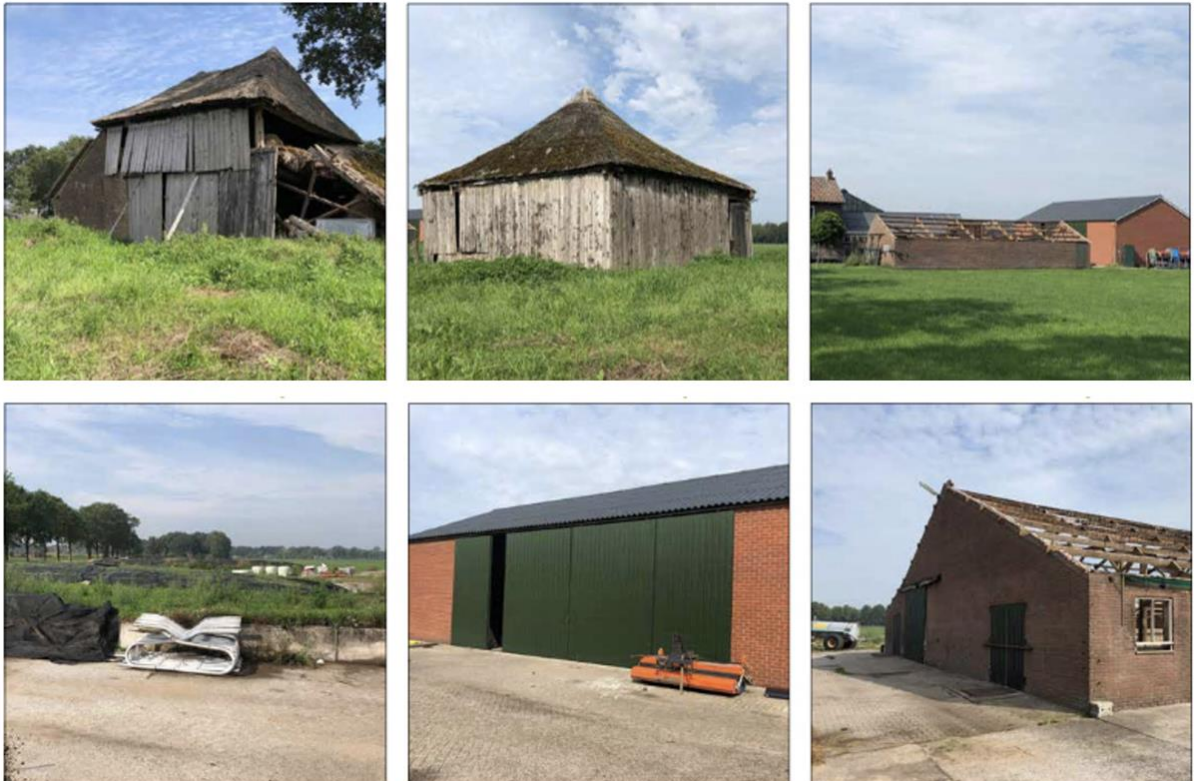
Afbeelding 2.3 Boven, van links naar rechts: te slopen en herbouwen historische steltenberg en vijfroedige hooiberg en te slopen bebouwing. Onder, van links naar rechts: op te ruimen kuilplaten, opgeknapte wagenberging en te slopen ligboxenstal (Bron: De Erfontwikkelaar)
