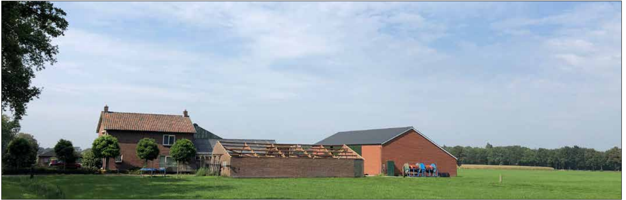
woning/te slopen schuur
