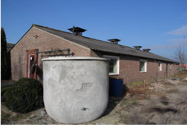
Fig. 3. Zuidoosthoek van het kantoorgedeelte.
