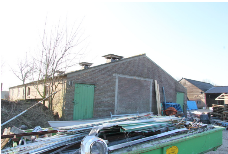
Fig. 5. Noordkant van het gebouw met opslagruimte.
