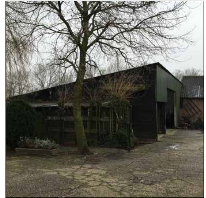
een te slopen bijgebouw
