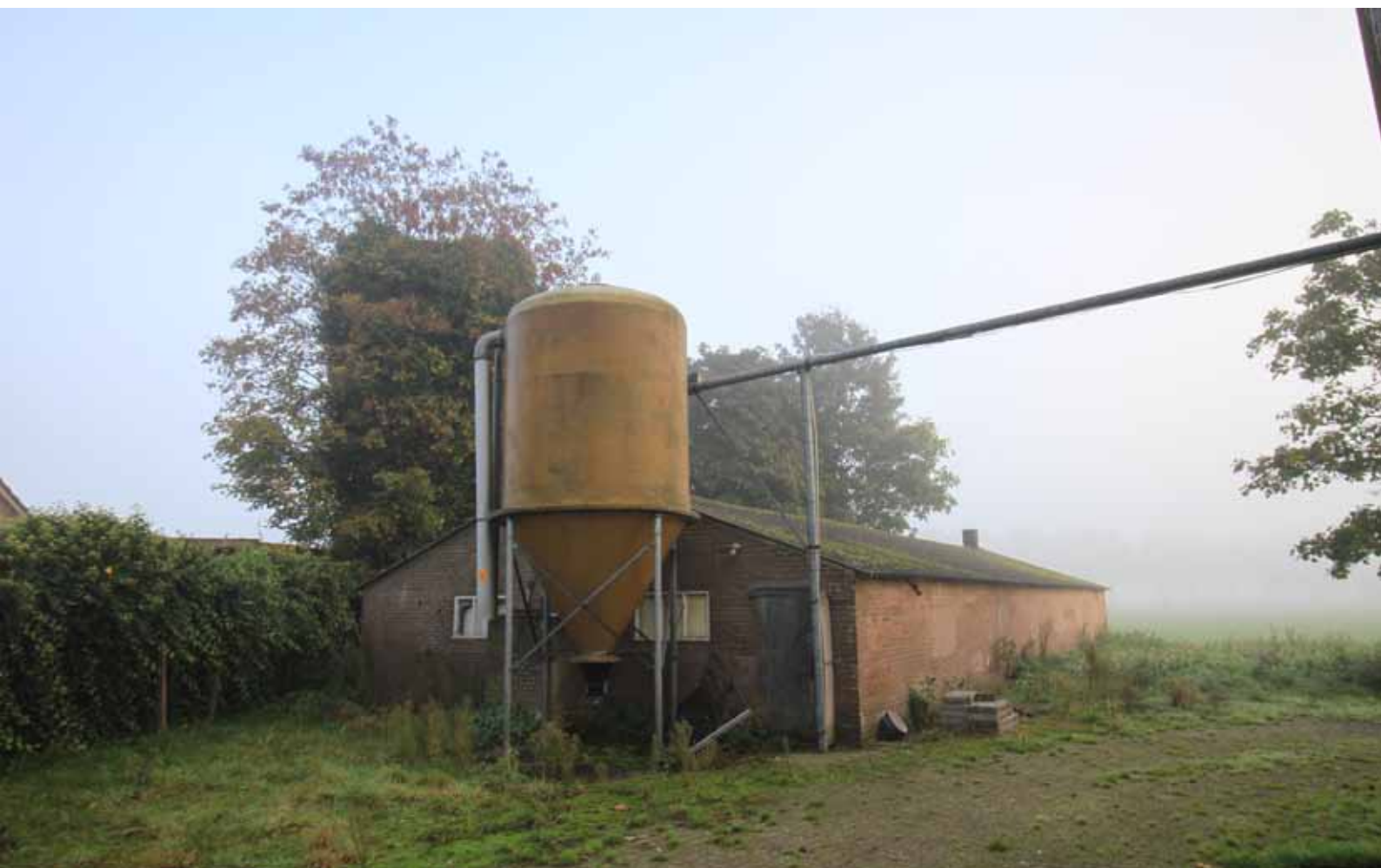
Afbeelding 7. Te slopen bebouwing
