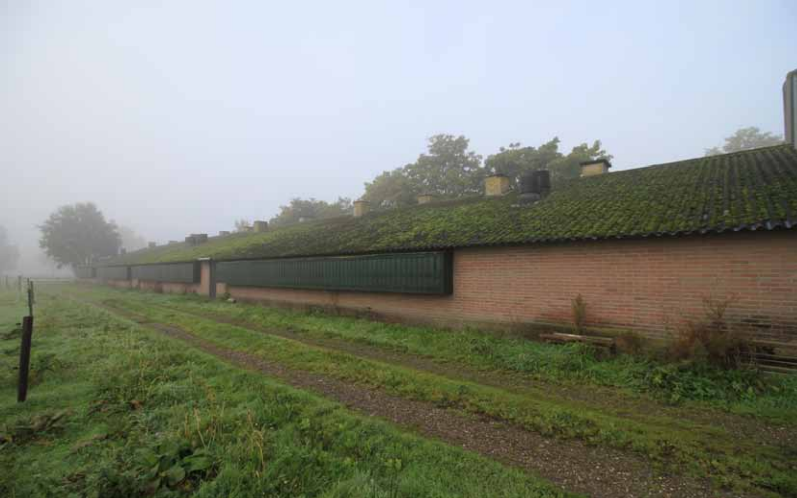
Afbeelding 6. Te slopen bebouwing
