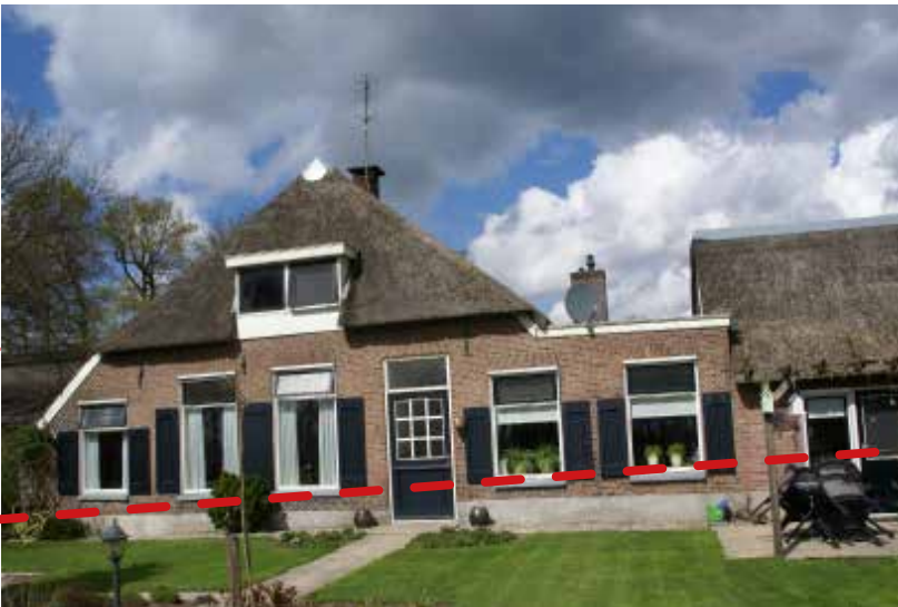
De voormalige boerderij wordt gesloopt
