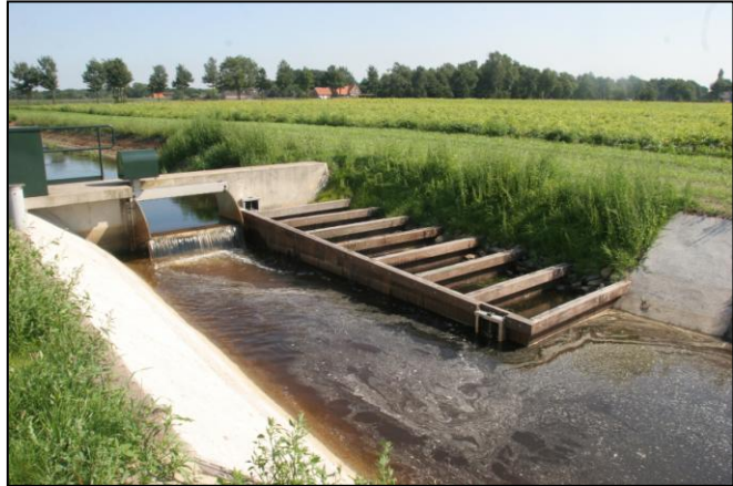
Figuur 3. Voorbeeld open De Wit-passage
