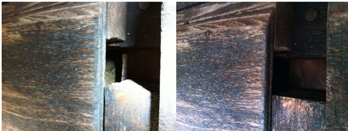
Mogelijke invliegopeningen van vleermuizen in de houten schuur.
