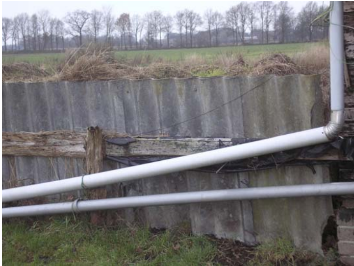
Foto 1: Asbestverdacht plaatmateriaal
