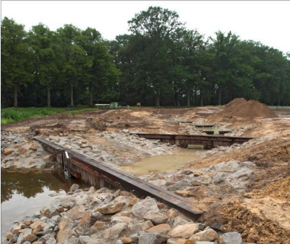
Figuur 2 Voorbeeld cascade vispassage
