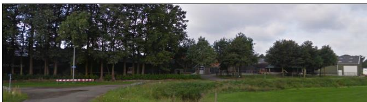
Figuur 2.3 Straatbeelden van de noordzijde (boven) en oostzijde (onder) (Bron: Google Streetview)
