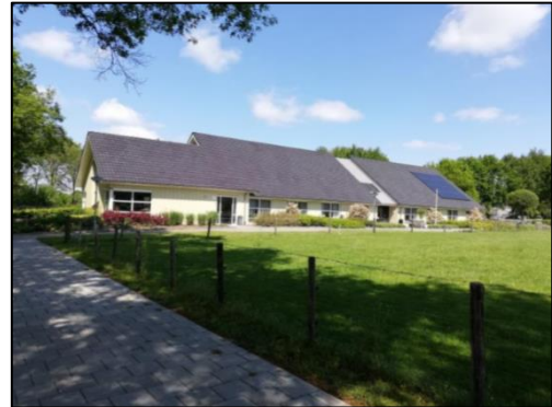
Nieuwbouw locatie Stevenserf
