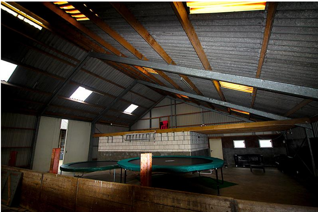
Planlocatie schuur binnenzijde
