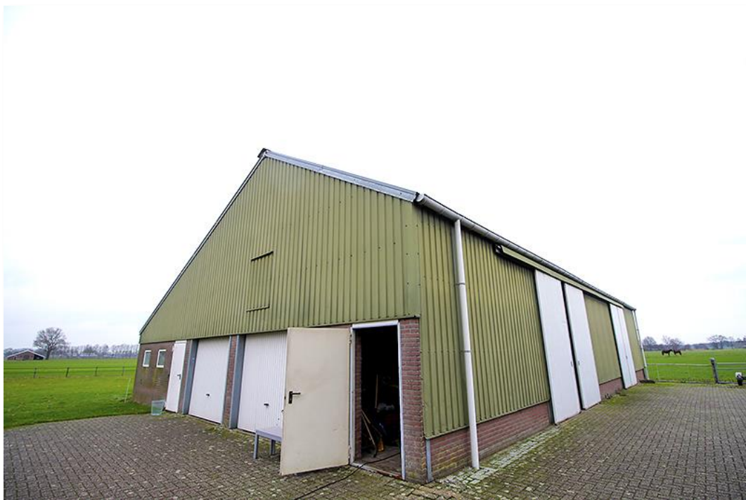
Planlocatie te slopen schuur
