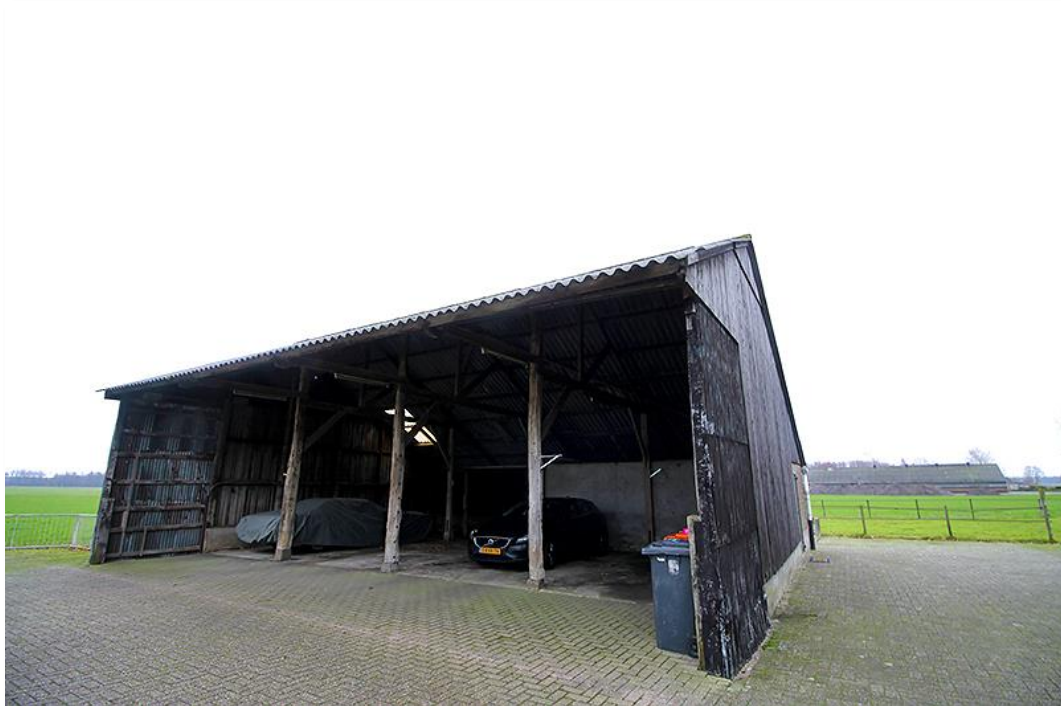
Planlocatie te slopen schuur
