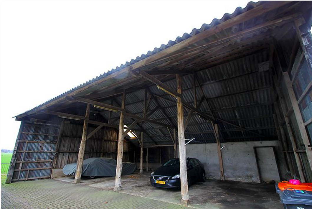
Planlocatie schuur binnenzijde
