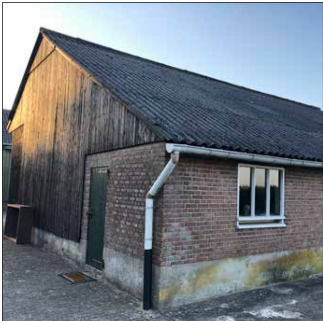
te slopen schuur
