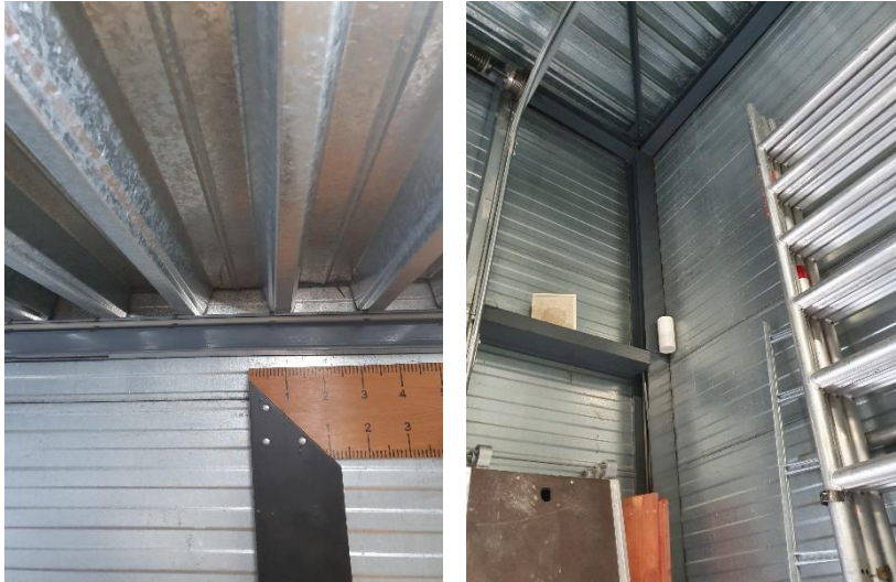
Afbeelding 18 Binnenkant te slopen bedrijfsgebouw
