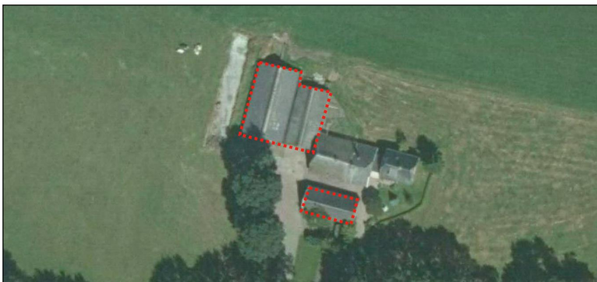
Afbeelding 3.1 Te slopen agrarische bebouwing op het agrarische perceel Hellendoornsweg 79 te Luttenberg (bron: Arcgis)
