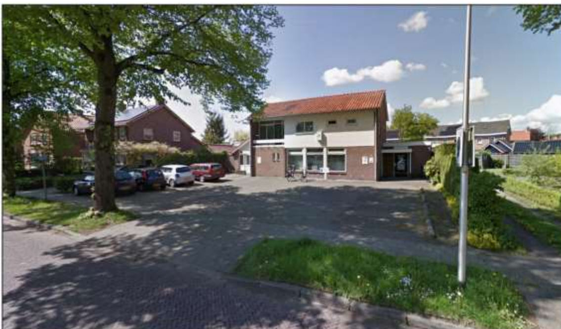
Figuur 2.2 Straatbeeld plangebied (Bron: Google Streetview)
