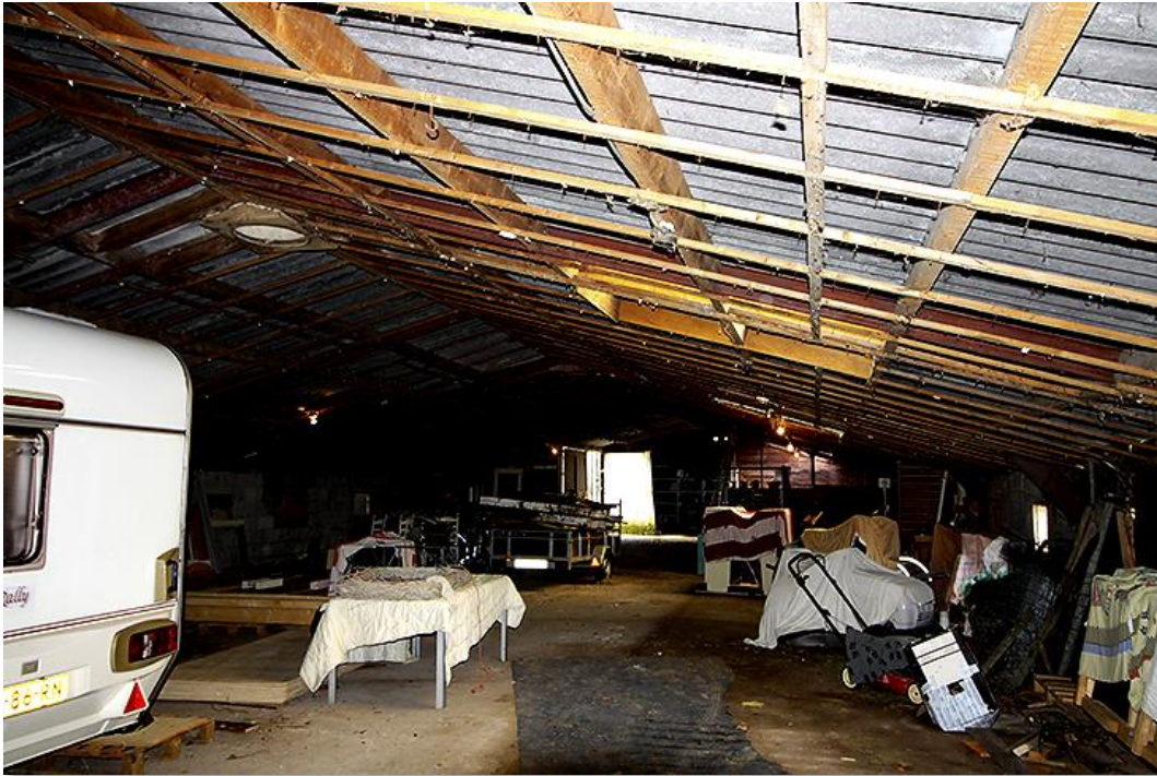
Plangebied zicht in zuidelijke richting
