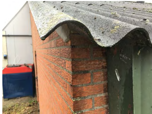
Figuur 13: Ontbreken van dakgoot
