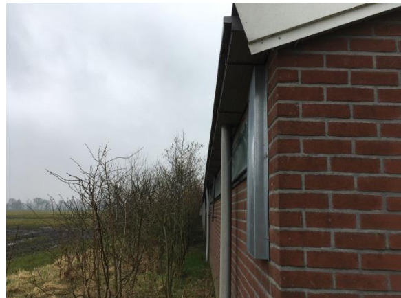
Figuur 13: Dakgoot bebouwing
