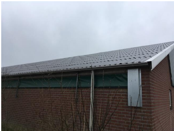
Figuur 12: Overzichtsfoto bebouwing
