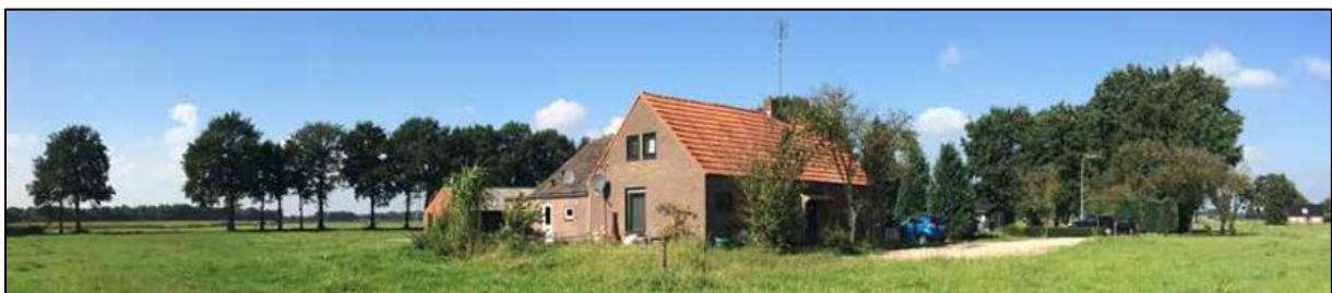
Huidige bebouwing op het erf.
