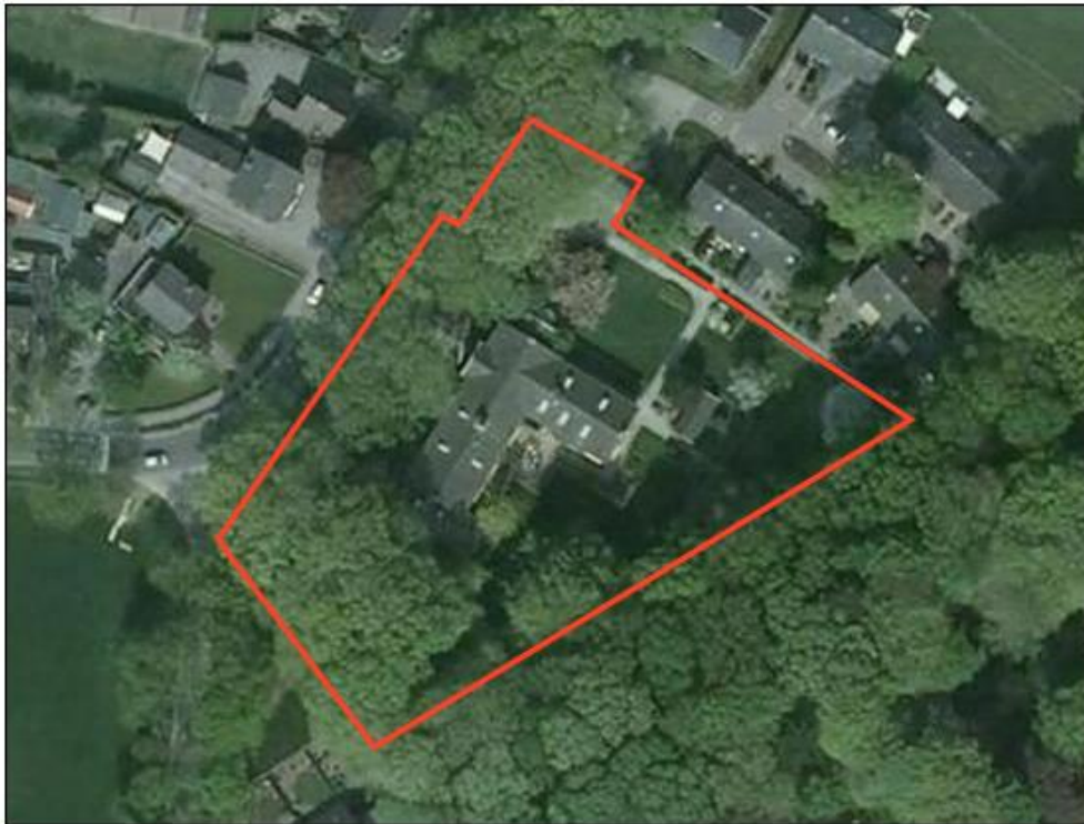
Afbeelding 2.3 Luchtfoto huidige situatie plangebied (Bron: Provincie Overijssel)
