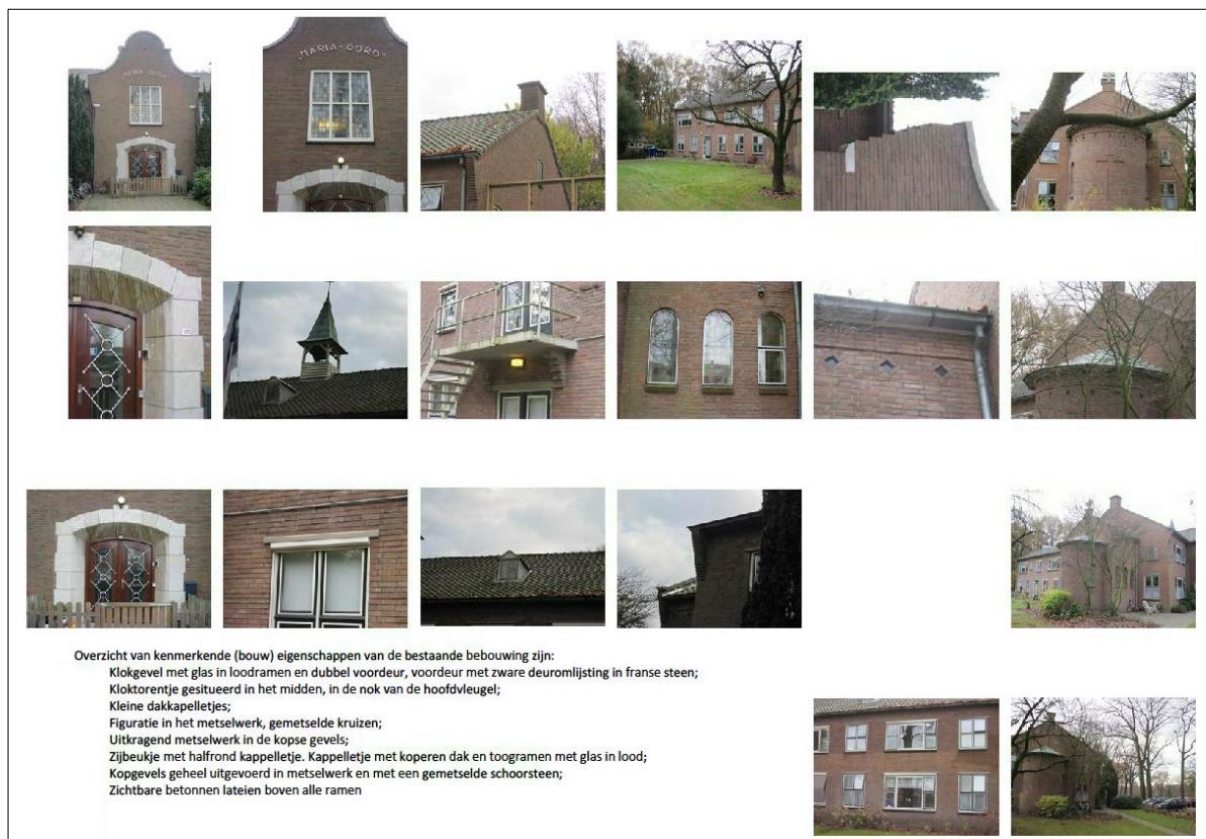
Afbeelding 3.4 Referentiebeelden nieuwbouw (Bron: H.A. ten Have)
