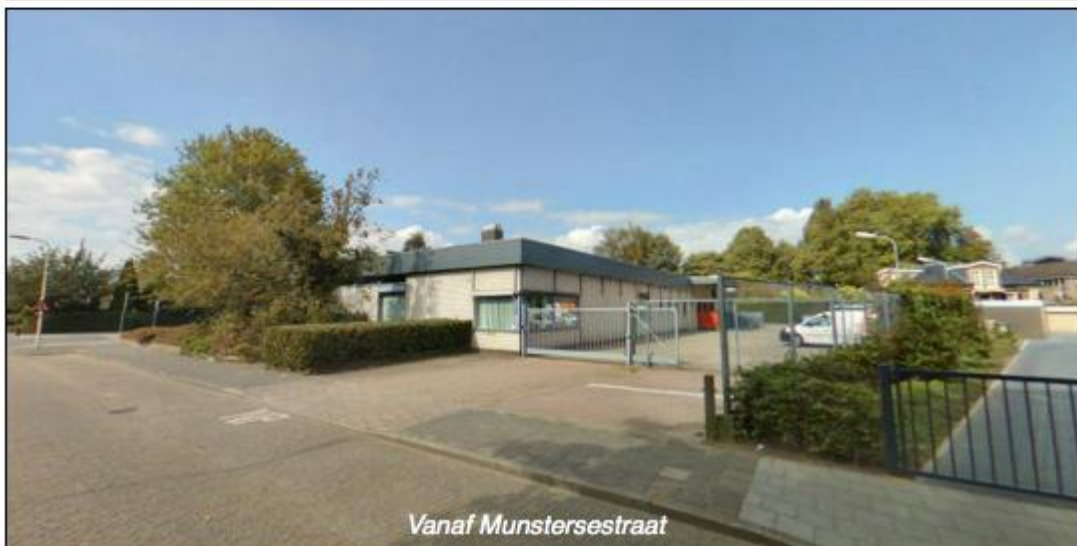
Figuur 2.3 Foto's van de huidige situatie (Bron: Cyclomedia)
