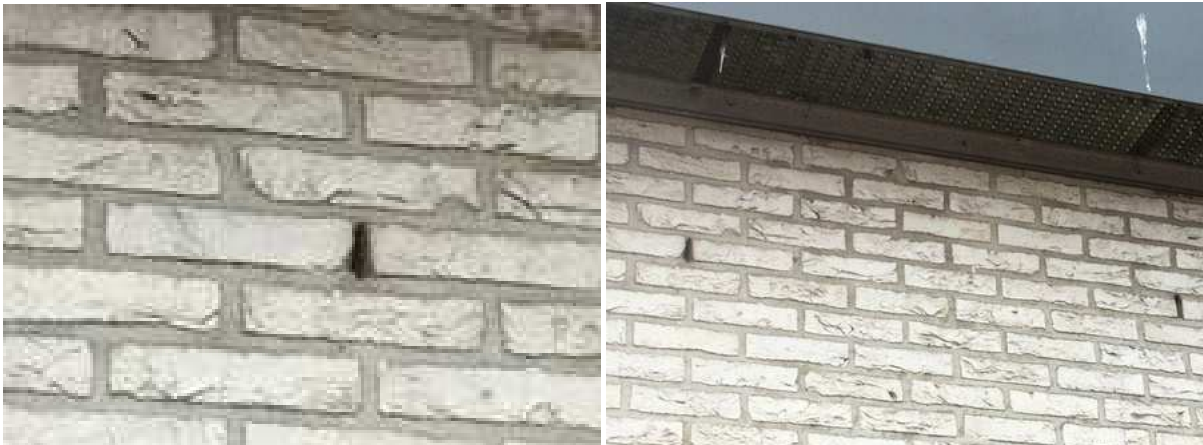
Reden voor nader onderzoek; open stootvoegen rondom in het gebouw, mogelijke invliegopeningen van verblijfplaatsen voor vleermuizen.
