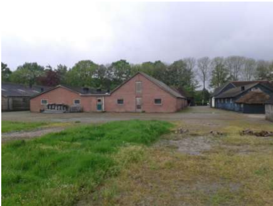
Figuur 9.1 Te slopen bebouwing in het plangebied (foto: M. Hoksberg).
