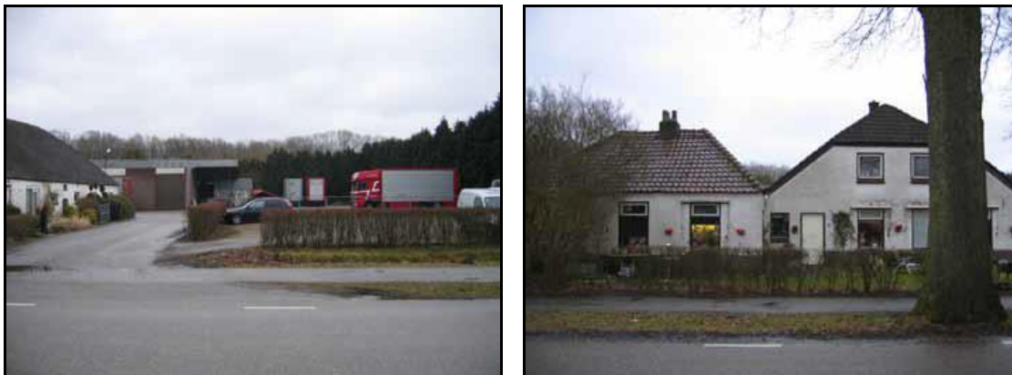
Voormalig aanzicht locatie Slotman vóór sloop bebouwing.
