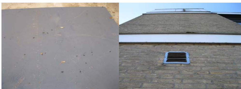
Foto 1: Links: Trappenhuis waar tijdens het veldonderzoek uitwerpselen van vleermuizen zijn aangetroffen. Rechts: Rooster en boeiplank met toegangsmogelijkheden voor vleermuizen.
