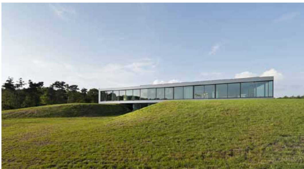
Afbeelding 72. Gebouw ligt echt op de grens, ligt deels vast en deels los
