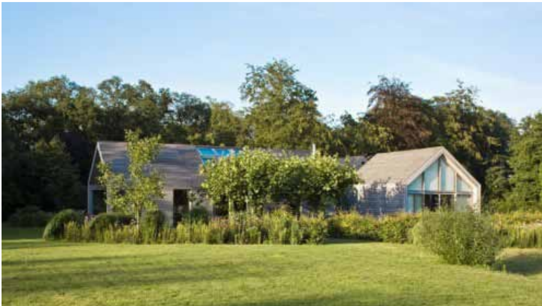
Afbeelding 69. Gebouw heeft vorm van schoor, ligt ingebed in landschap door gebruik landschapselementen
