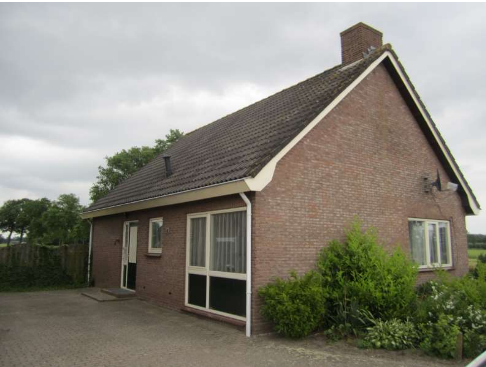
Foto 2. Het af te breken woonhuis.
