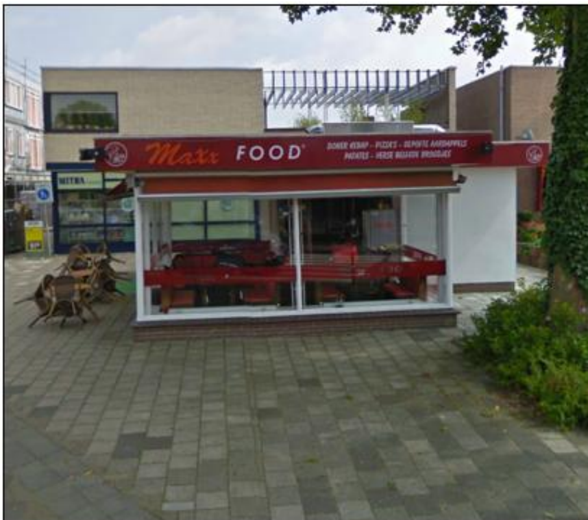
Figuur 2.1 Bestaande gebouw gezien vanaf de Brugstraat (Bron: Google Streetview)
