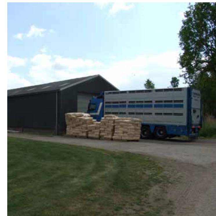
Bestaande relatief jonge agrarische schuur. Deze schuur wordt in het kader van r.v.r. gesloopt.
