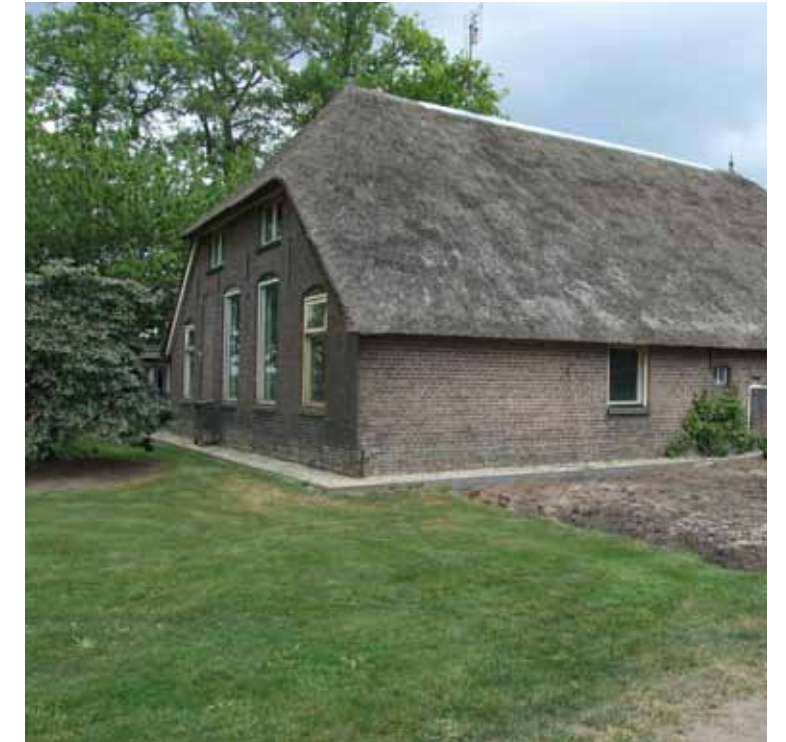
Bestaande en te renoveren Salllandse boerderij.
