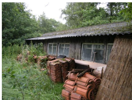
Dakpannen tegen achterzijde schuur
