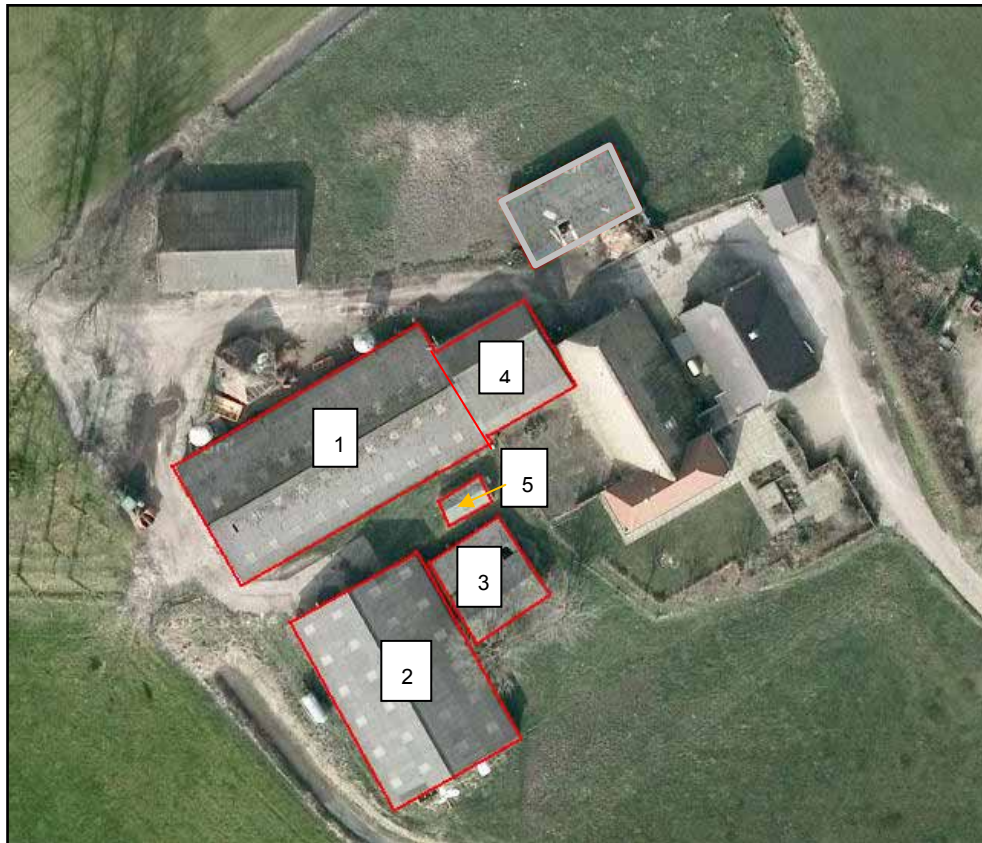
Luchtfoto met te slopen bebouwing
