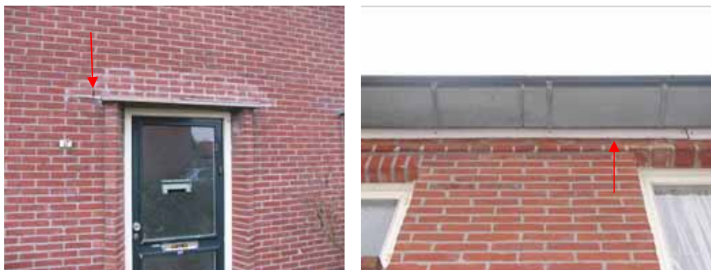
Afbeelding 3: mogelijke toegangen tot verblijfplaatsen van vleermuizen.
