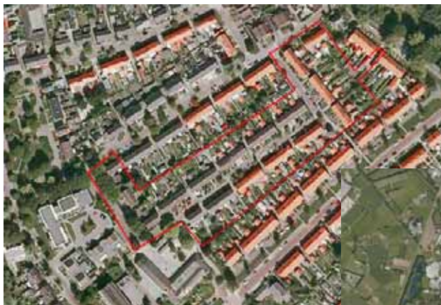
Luchtfoto van het plangebied en de kern Raalte
