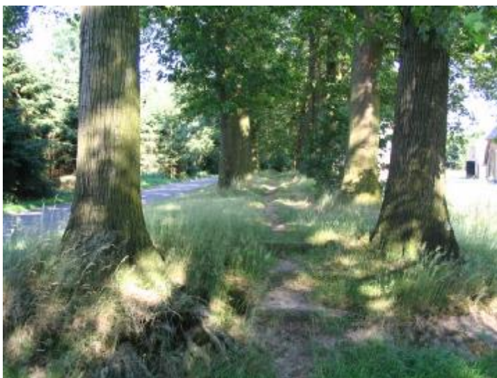
De zeewaterkering langs de Zuthemerweg
