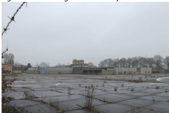
Figuur 4.7 Voormalige terrein betonfabriek MBI
