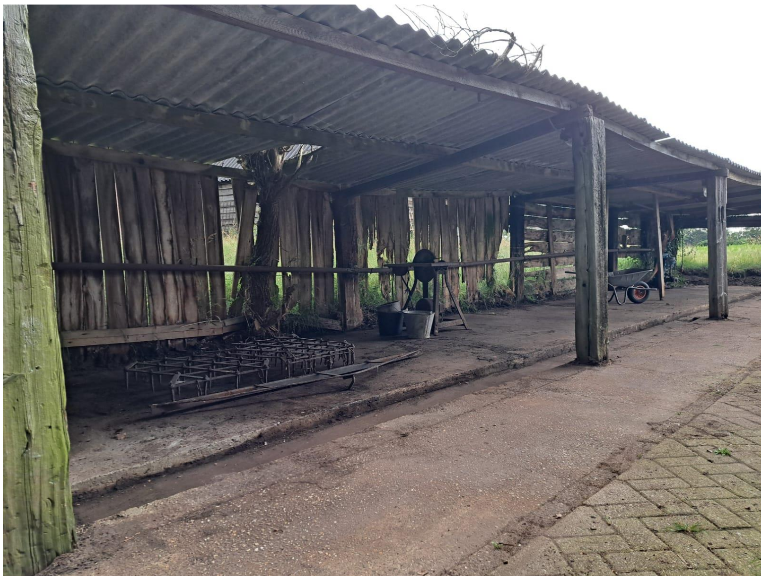
Afbeelding 7. Zicht vanaf het erf op de overdekte opslagplaats.
