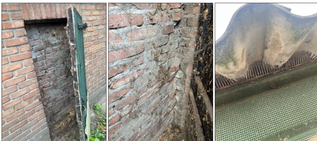
Foto links: deurtje in varkensstal 1. Foto midden: aan de binnenzijde van varkensstal 1 is koud tegen de buitengevel een binnenmuur gemetseld. Geen sporen van vleermuis aanwezig. Foto rechts: faunaweringsvoorziening onder de golfplaten.
