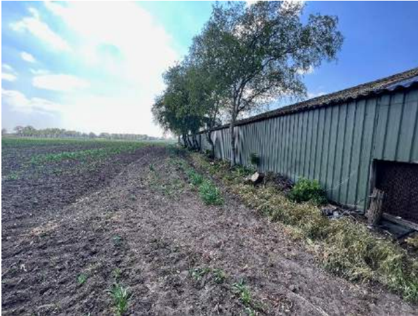
Figuur 09: Onverharde afwateringszone
