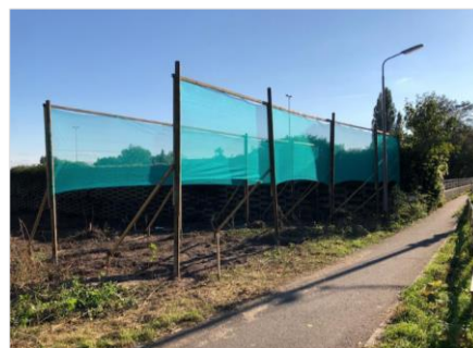
Figuur 6.1 voorbeeld van een vleermuis scherm (bron: Rijkswaterstaat).
