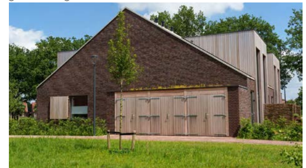
Rug-aan-rugwoning met mee ontworpen bergingen aan de kopgevel
