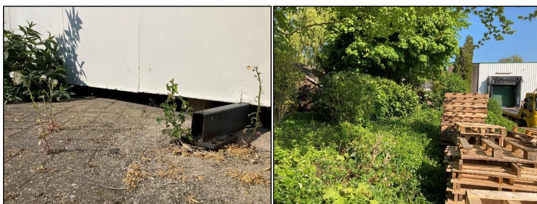
Figuur 6.4 (links): Een kier met achterliggende ruimte waar een marterachtige of egel zich kan schuilhouden of er zelfs een voortplantingsplaats kan hebben; Figuur 6.5 (rechts): Dichte begroeiing naast een stapel pallets, niet alleen in de begroeiing maar ook onder de pallets kunnen marterachtigen en egels een schuilplaats bezetten.
