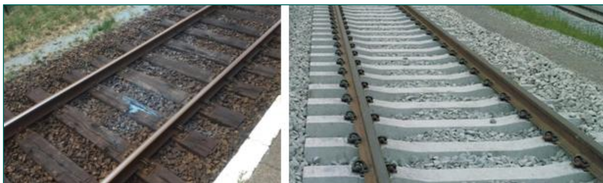
Figuur 18: Dwarsliggers, links bielzen, rechts beton (Bron: REASeuro-database).
