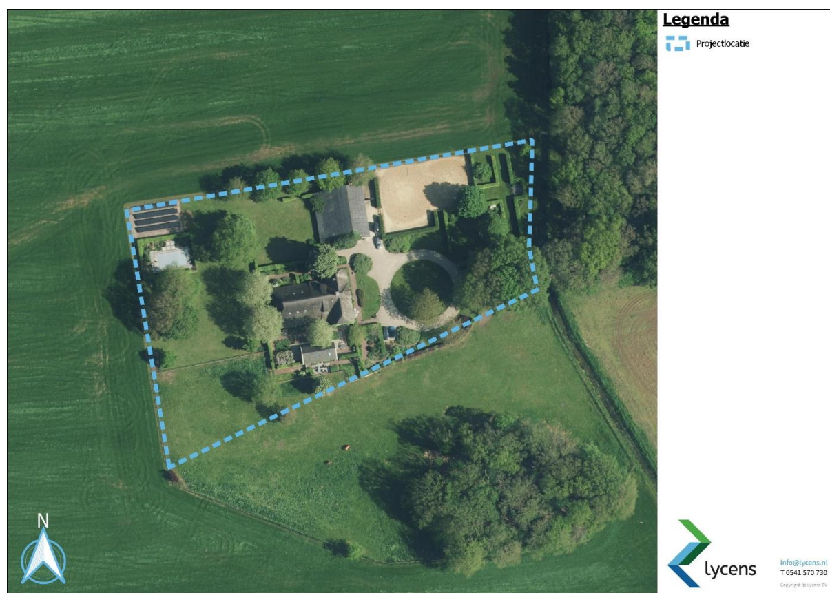
Figuur 4. Luchtfoto bestaande situatie Schaarsweg 12, Nieuw Heeten
